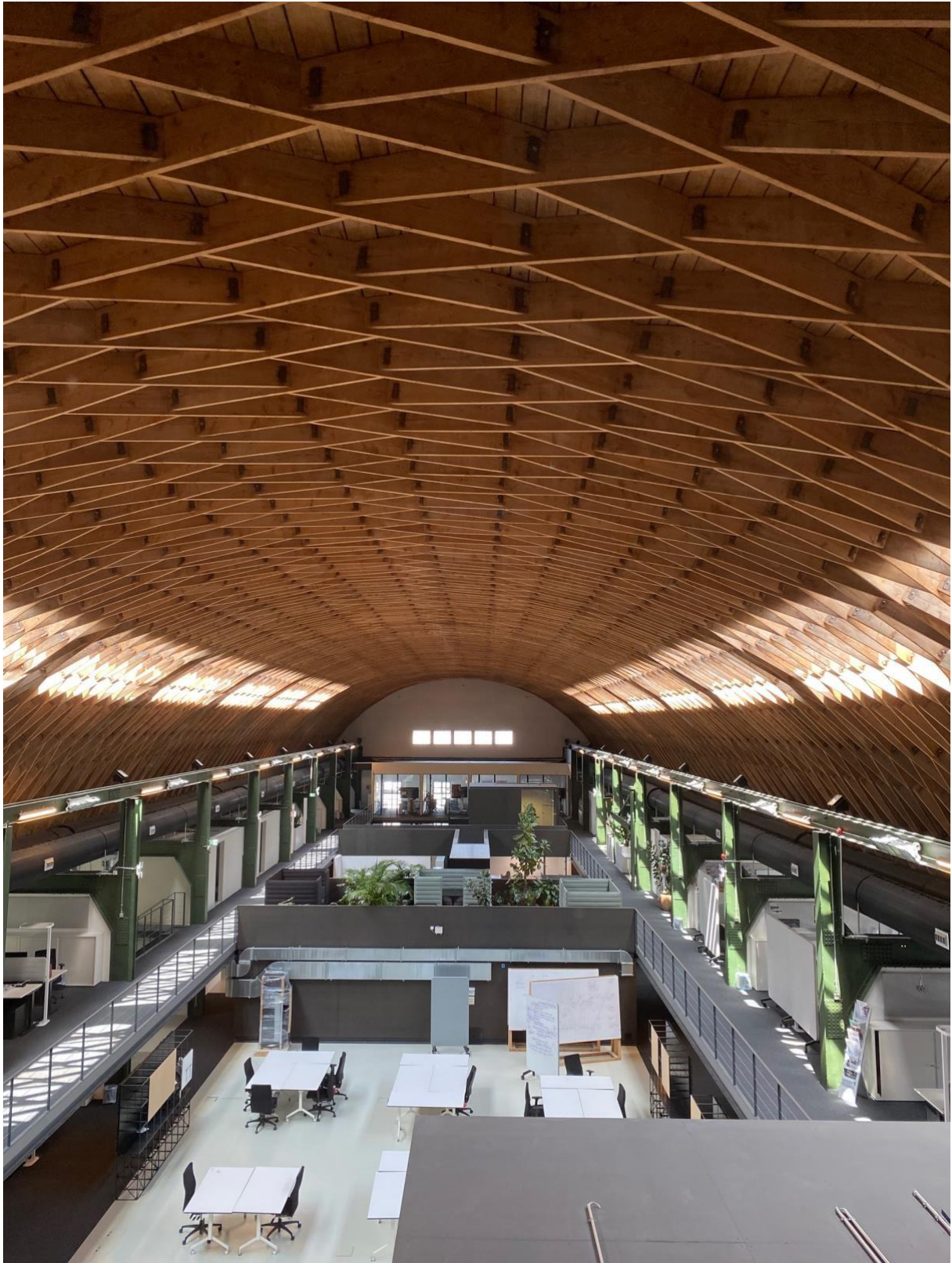
Innenansicht der Zollinger-Halle in Ludwigsburg
